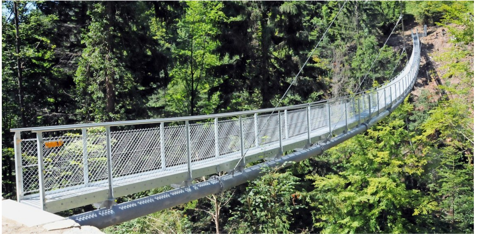
Blick auf die neue Einseilhängebrücke in den Tagen vor der Einweihung. Sie steht etwas weiter seewärts als die alte.
