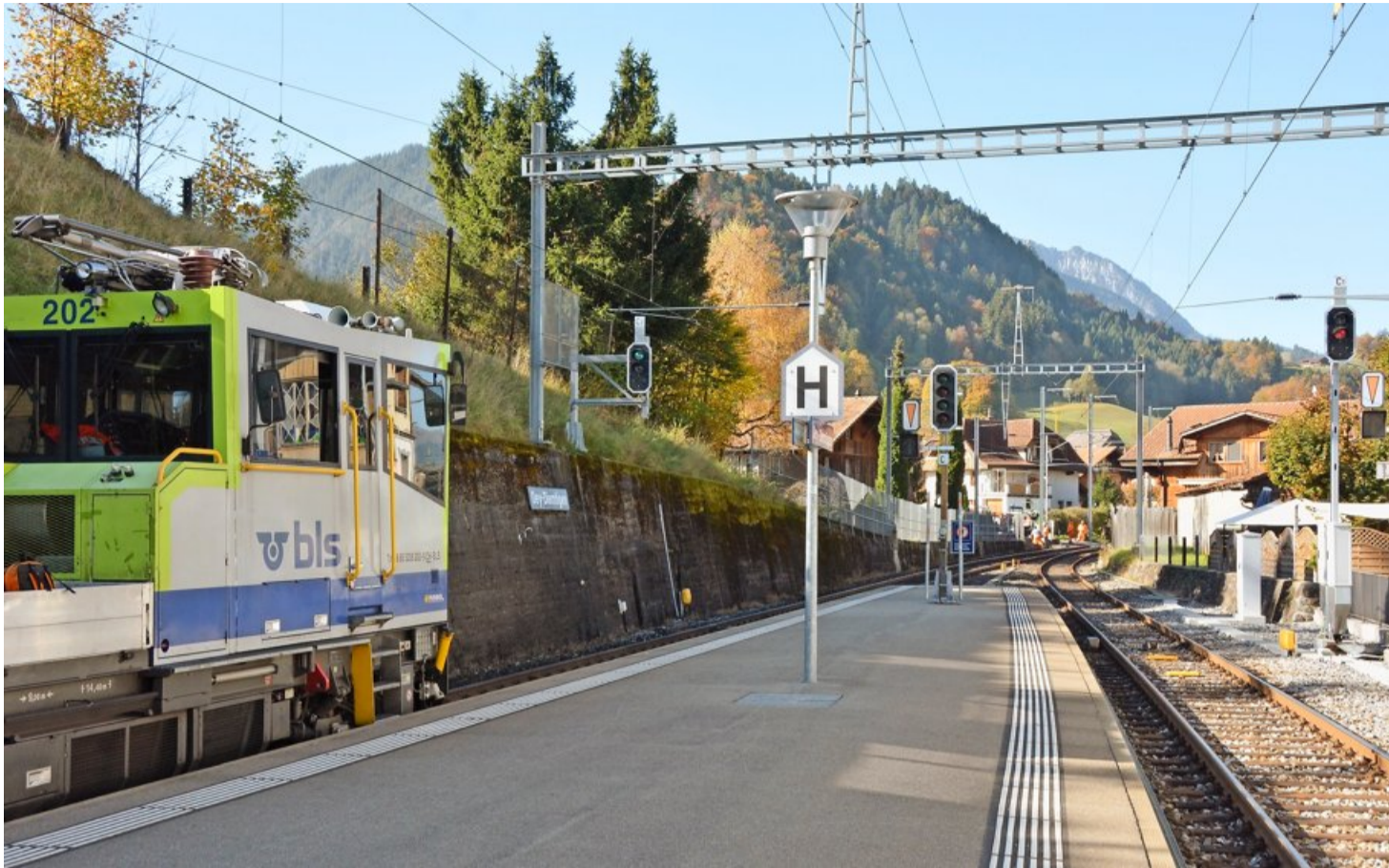
Im Bahnhof Oey-Diemtigen: Der Bauzug erhält bereits vom neuen Ausfahrtsignal (links) freie Fahrt. Das dunkle Gruppensignal in der Mitte wird zurückgebaut.
