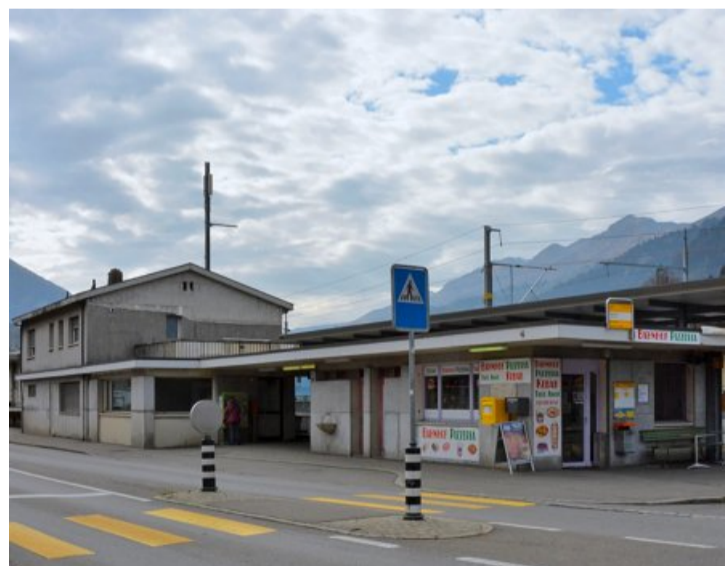
Die Altlast hat bald ausgedient: Das aus dem Jahr 1964 stammende Bahnhofsgebäude Reichenbach wird durch einen Neubau ersetzt. Guido Laufer
