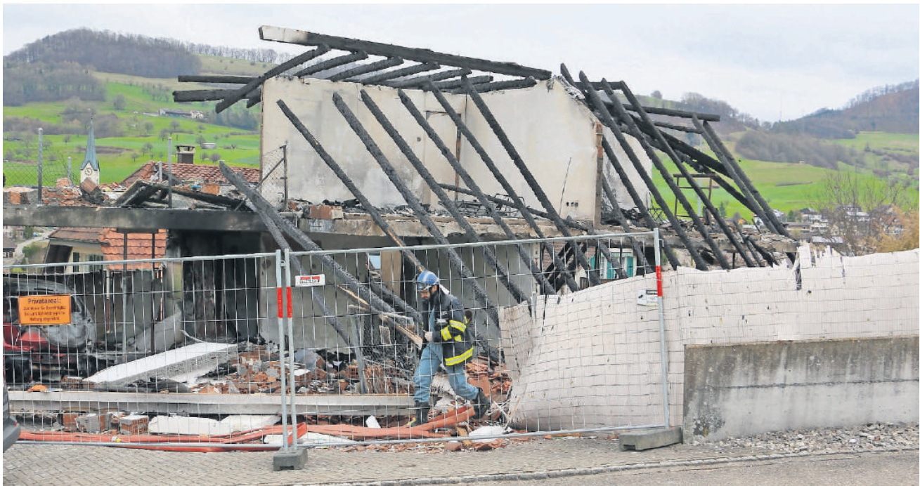
Beim verheerenden Brand ist das Einfamilienhaus bis auf die Grundmauern abgebrannt. Zwei Menschen kamen hier in der Nacht auf Sonntag ums Leben.
