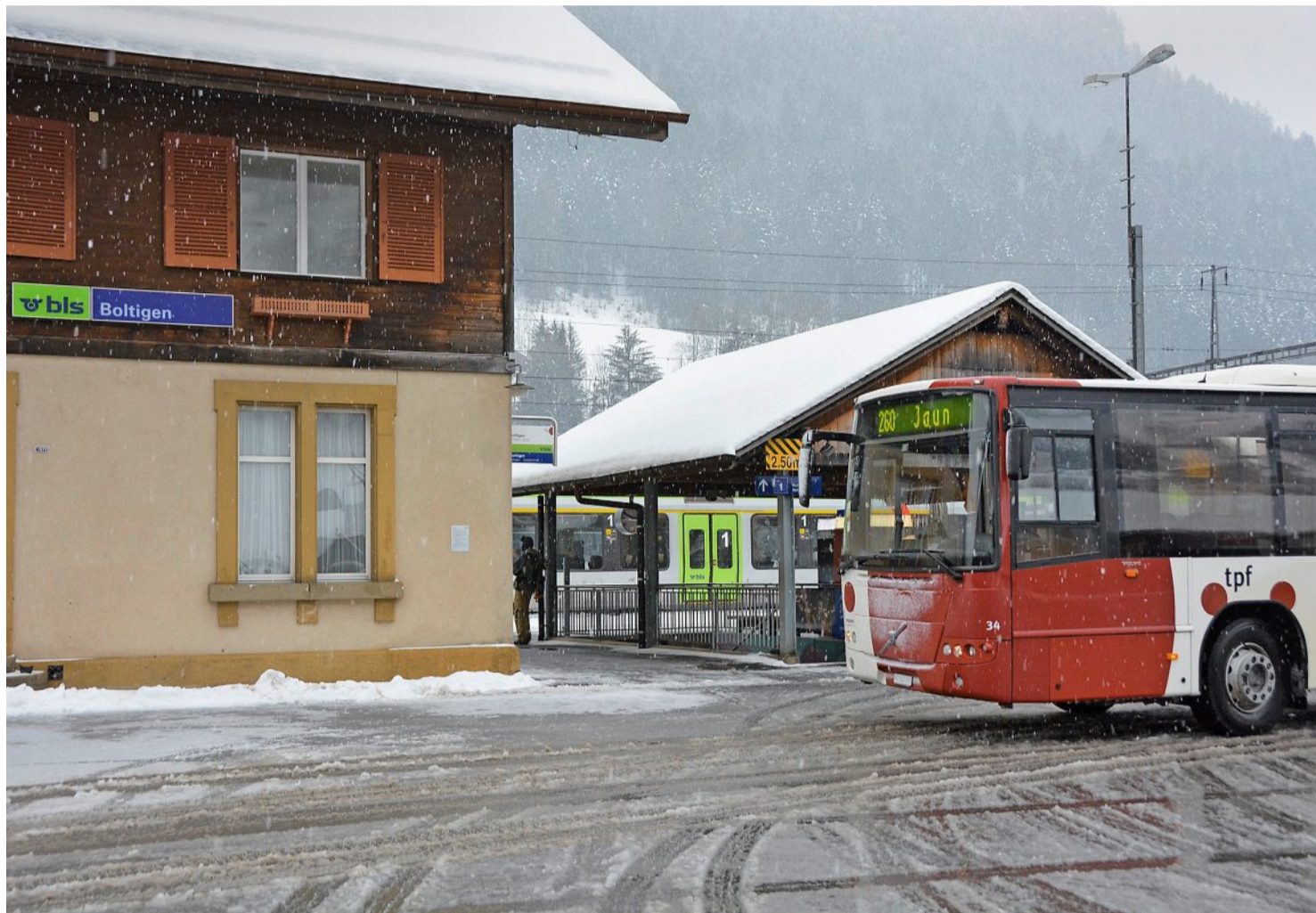
Verkehrsknotenpunkt Boltigen: Bus und Bahn sollen hindernisfrei miteinander verbunden werden. Foto: Guido Lauper
