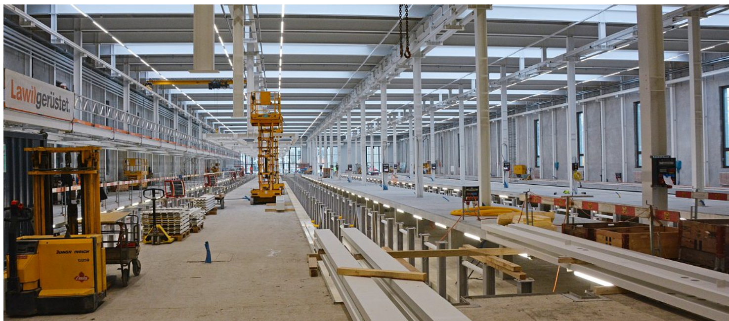
Ein Riesenteil: 765 Tonnen teils bereits bei der Fabrikation endbeschichteter Stahl wurden für die 145 Meter lange Halle verbaut. Foto: Guido Lauper
