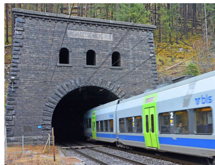
Nichts weist am Lötschberg-Nordportal auf die vierjährigen Sanierungsarbeiten im BLS-Scheiteltunnel hin.
