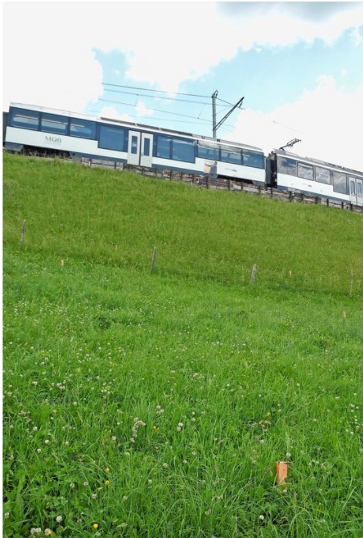
Mit Bahnschienen und -schwellen wurde das Trassee gesichert. Im Hang verweisen Markierungen auf die geplanten Sickerbetonriegel.
