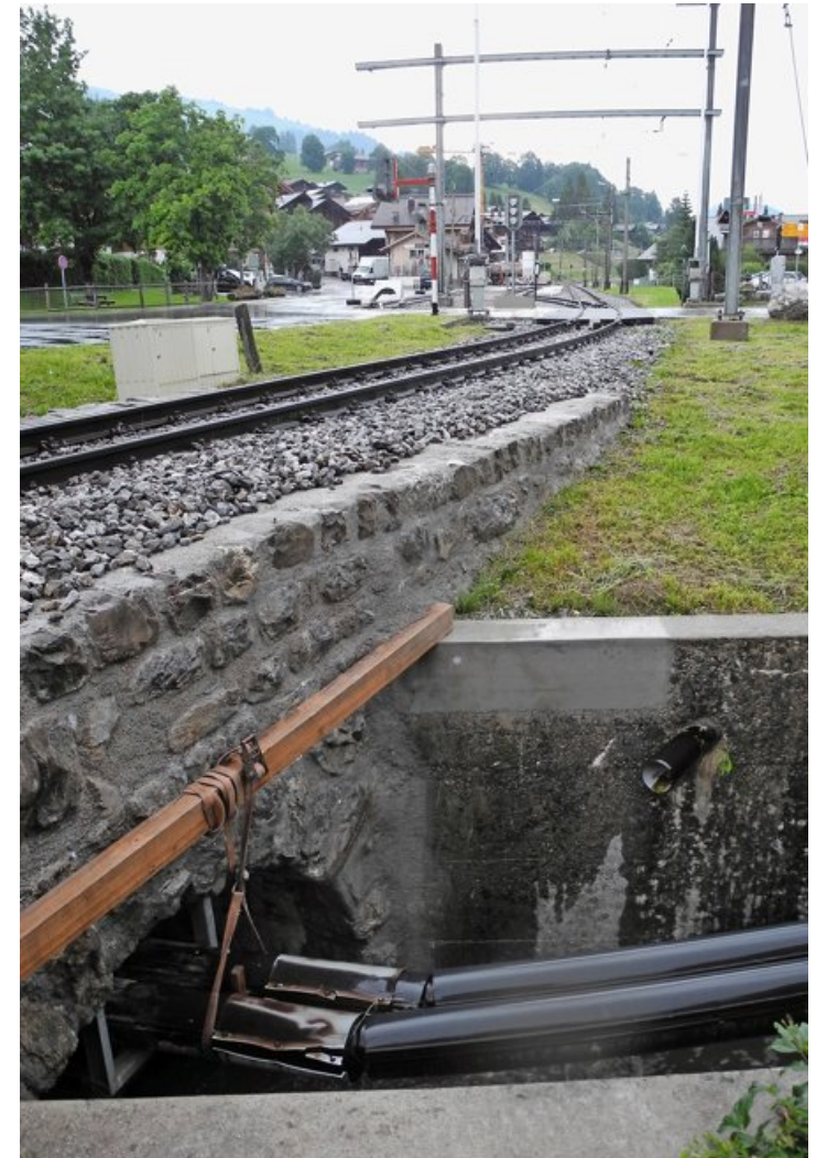
Die provisorisch montierte Fernwärmeleitung unter der Brücke über den Choufflisbach bei Schönried soll in der Erde verschwinden. Fotos: Guido Laufer
