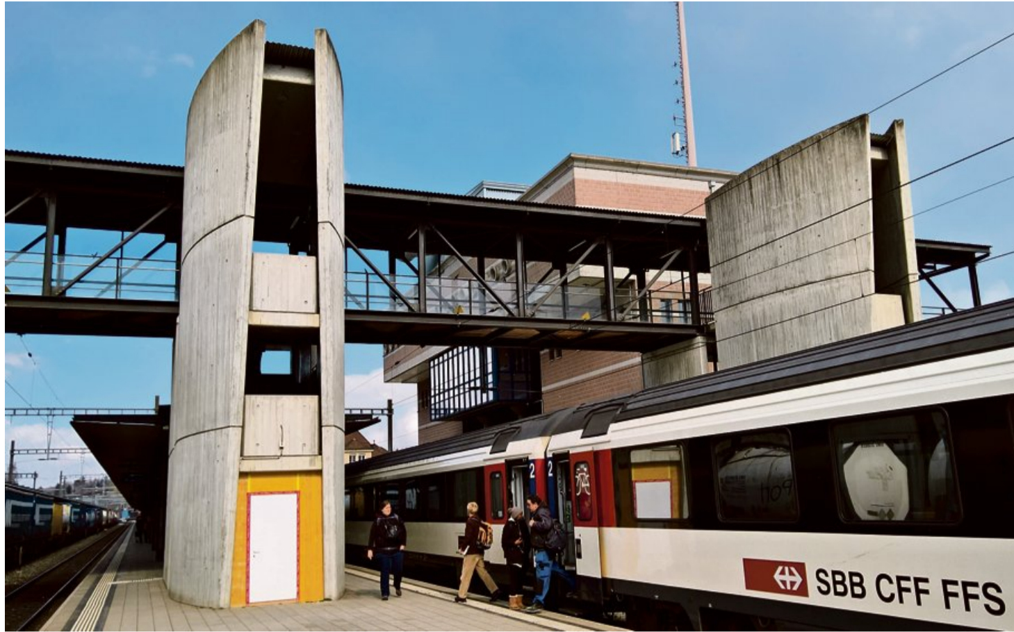
Die gelben Schalttafeln und weissen Türen an der transparenten Passerelle sollen ersetzt werden.
