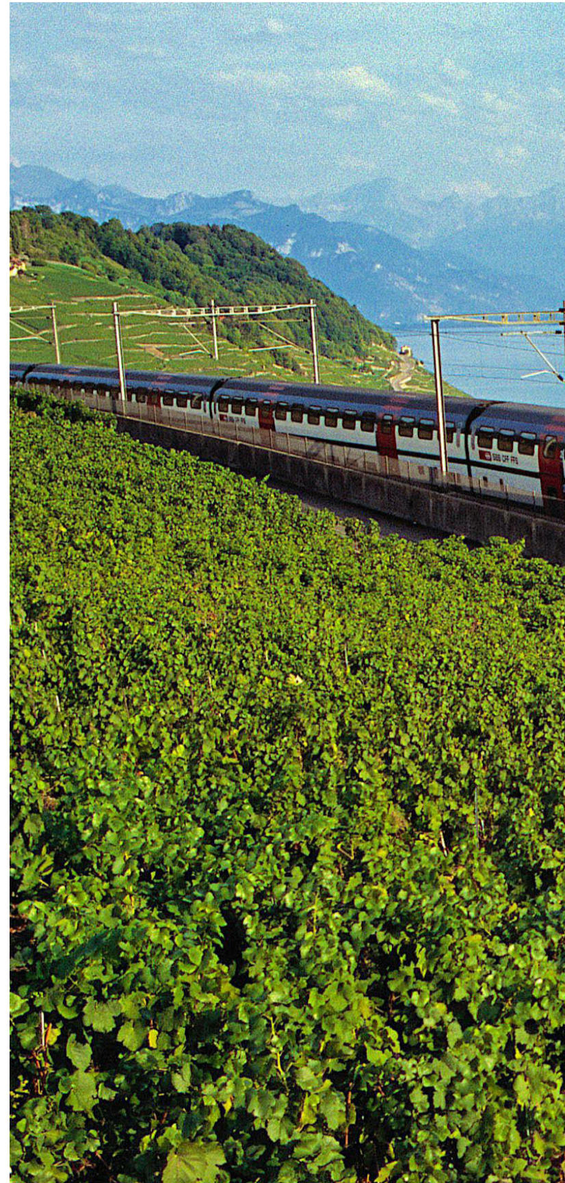
Entre 2025 et 2035, les CFF devront remplacer 146 kilomètres de voies sur
