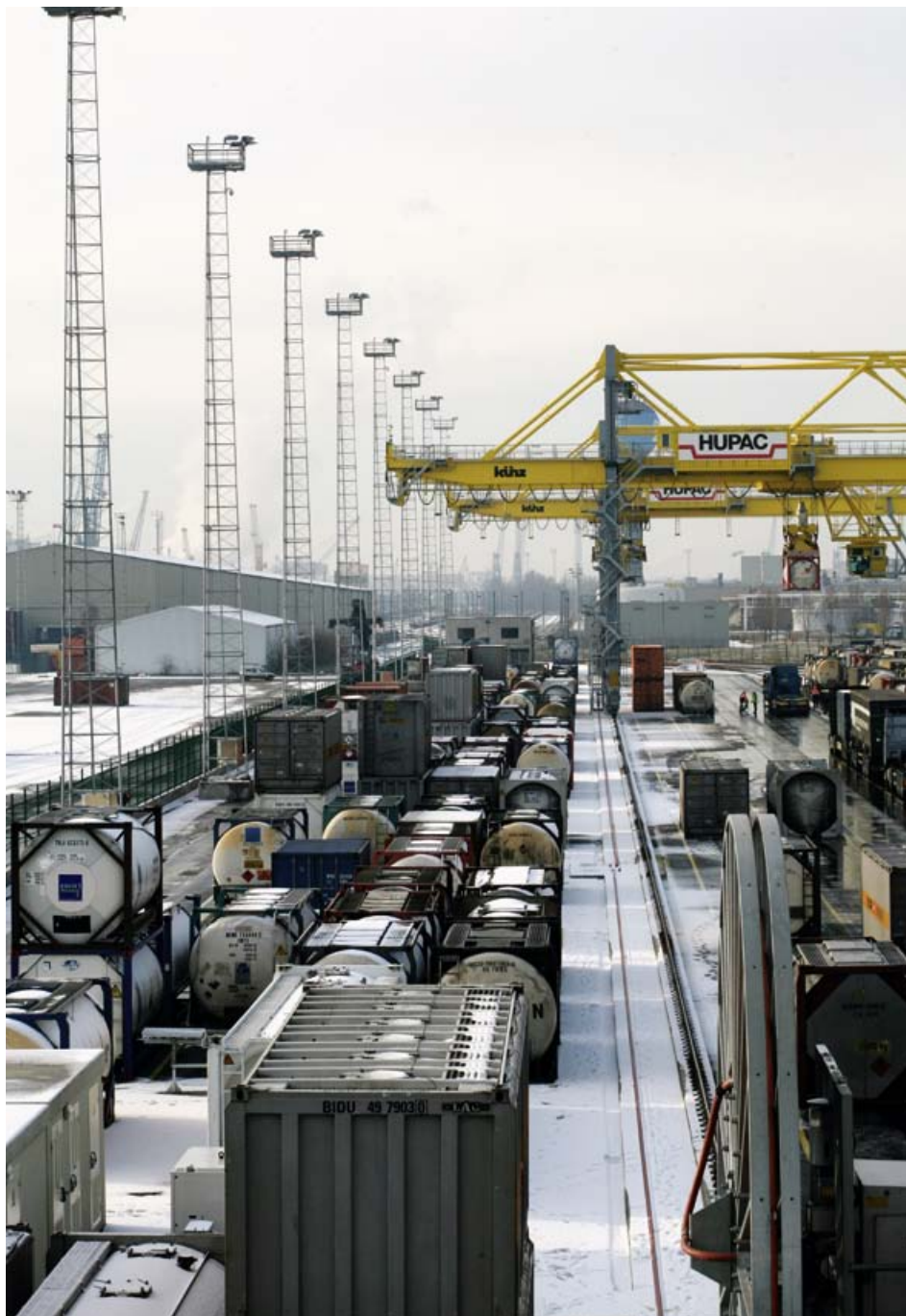
Der neue Terminal erstreckt sich über 53 000 m 2 und umfasst 5 Gleise von 620 m Länge, 2 LKW-Spuren und 6 Parkreihen für Behälter.
