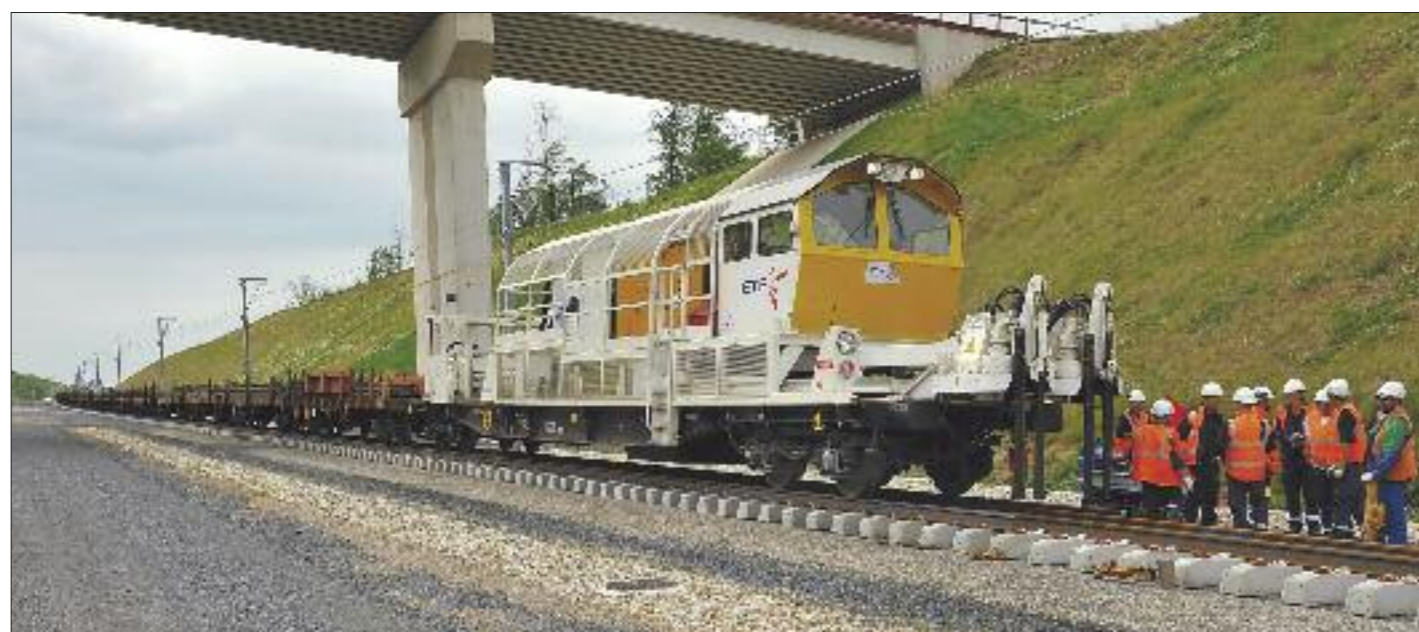
L'une des grandes innovations du chantier de la LGV Est phase 2 : le wagon pousseur de rails d'ETF (mai 2014).
