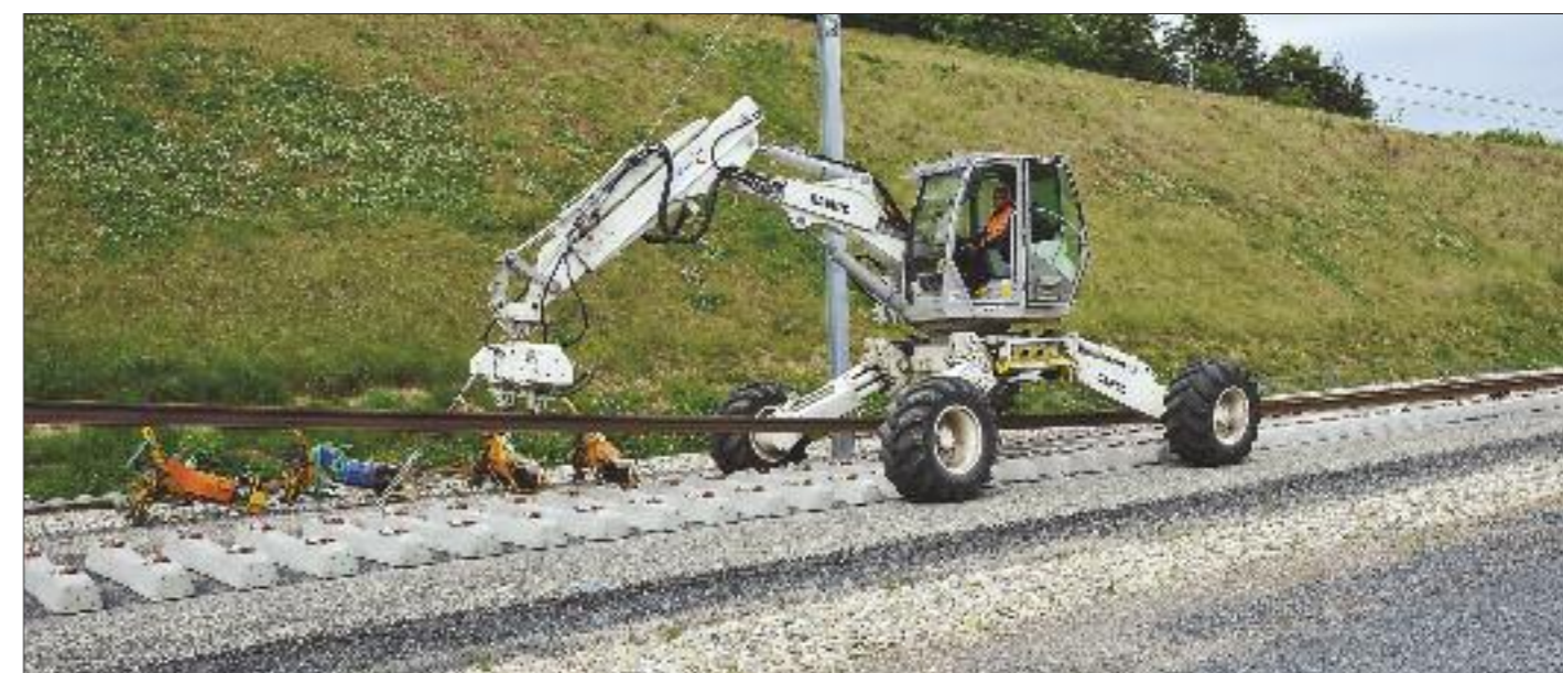
De haut en bas : goujon sur le mât caténaire servant à certaines opérations importantes dont le travail en BAS ; pose des rails sur la section Baudrecourt - Vendenheim de la LGV Est (mai 2014).
