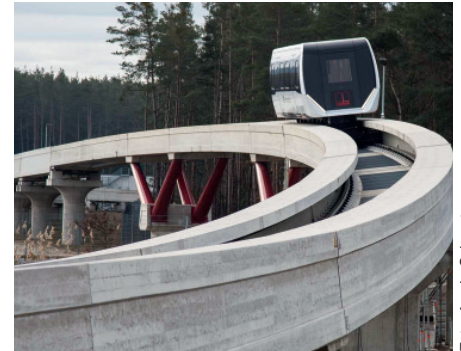
Abb. 3: Flexible Streckenführung: aufgeständert, ebenerdig und in kleinen Radien.
