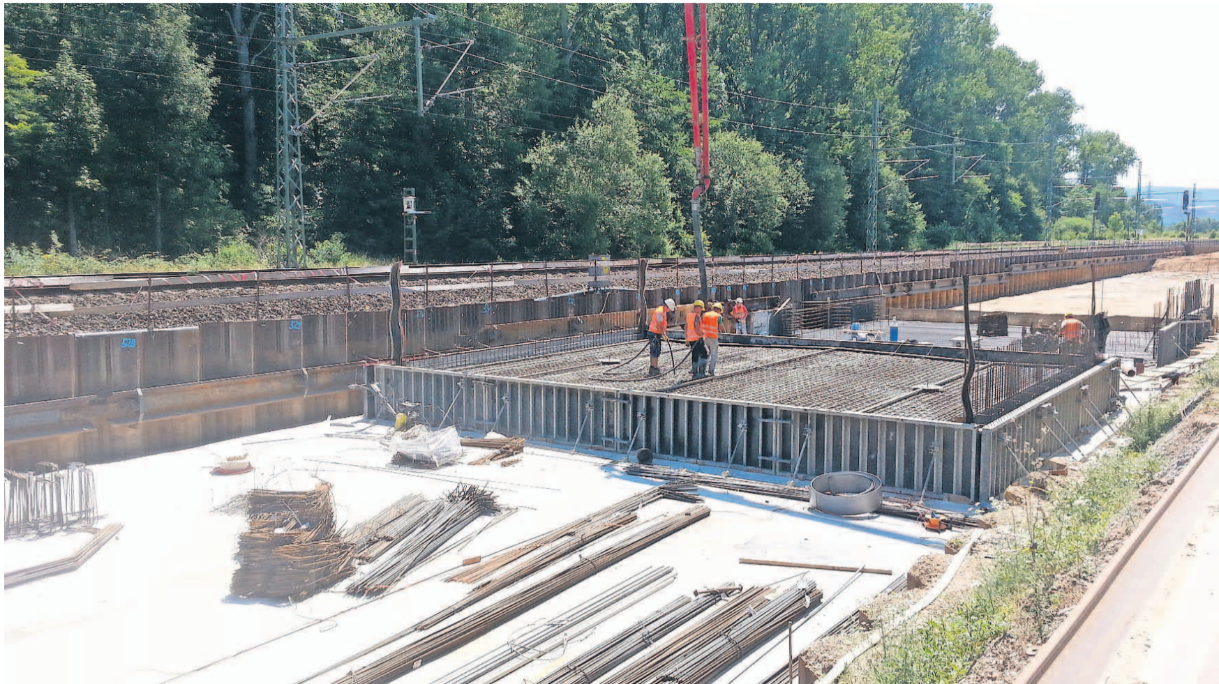
Die Verdoppelung auf ein 3. und 4. Gleis bei Rastatt; gleich neben dem Trasse der alten Rheintalbahn entstehen die Zufahrten zum künftigen Tunnel.
