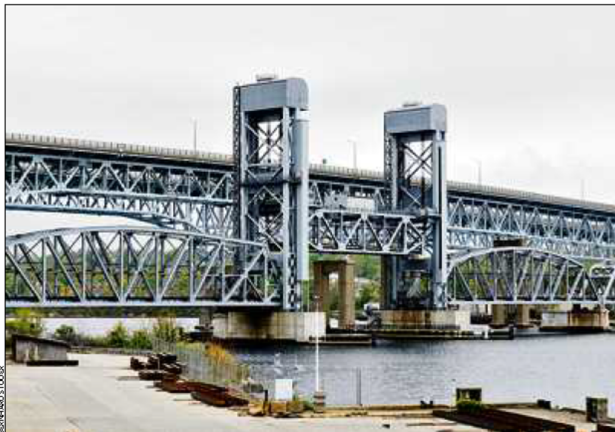
Viaduc routier et pont ferroviaire sur la Thames River. Lorsqu'un remorqueur doit tracter un sous-marin en direction de la base navale, la partie centrale du pont ferroviaire s'élève. NEW LONDON, 16 MAI 2014
