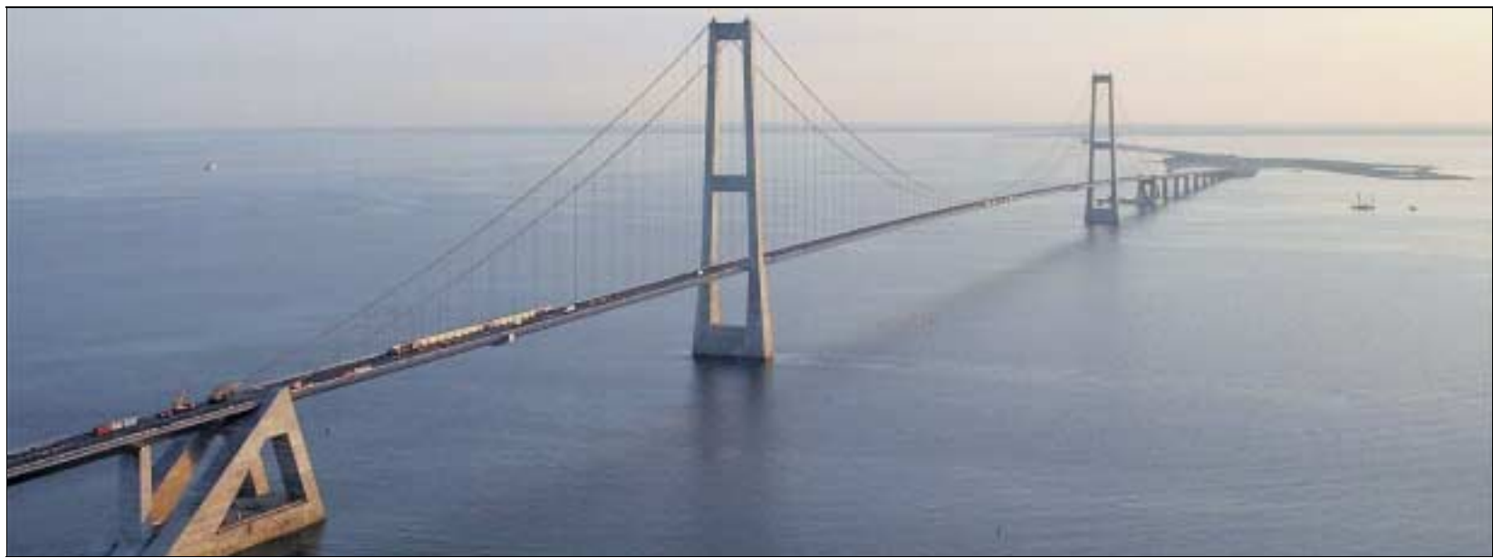
Die Brücke über den Grossen Belt, die Meeresstrasse zwischen den Inseln Seeland und Fünen.
