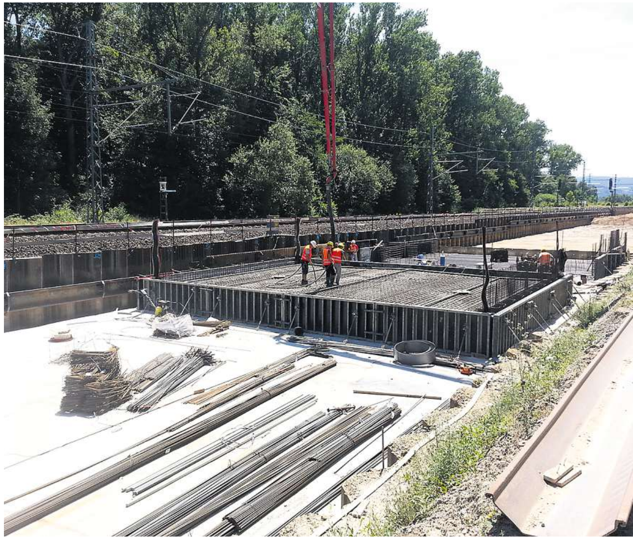
Neubaustrecke Karlsruhe–Basel: Gleich neben dem Trasse der alten Rheintalbahn entstehen bei Rastatt ein drittes und viertes Gleis. Bild Gerhard Lob
