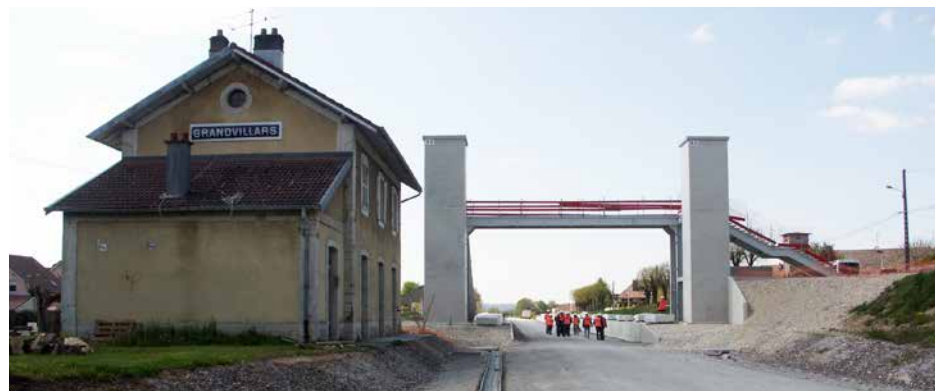
In Frankreich entstehen zwischen Belfort und Delle sechs neue Haltestellen. Im Bild diejenige beim alten Bahnhof in Grandvillars, in Richtung Belfort. Sie wird mit einem Ausweichleis ausgerüstet.
