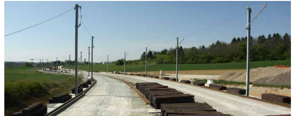
Bei der neuen Haltestelle Meroux, oberhalb des Bahnhofs Belfort-Montbéliard TGV. Die Bauarbeiten an der 22 Kilometer langen Bahnlinie mit TGV-Anschluss begannen im Herbst 2015.
