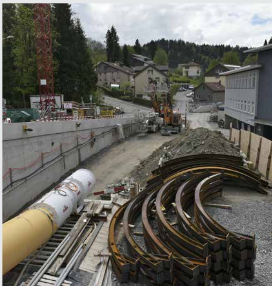
Der Installationsplatz beim Südportal des Ruckhaldetunnels. Hier entsteht die neue Haltestelle Riethüsi. Der Tunnel misst 700 Meter und macht die bisherige Zahnradstrecke überflüssig.
