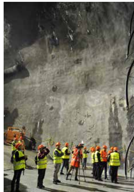
Der neue Albulatunnel II führt durch die geologische Störzone Raibler Rauwacke mit Wasser und Schlamm. Von der riesigen Kaverne aus wird sie über Bohrlöcher vereist (rechts), bevor der Tunnelausbruch weitergeht.
