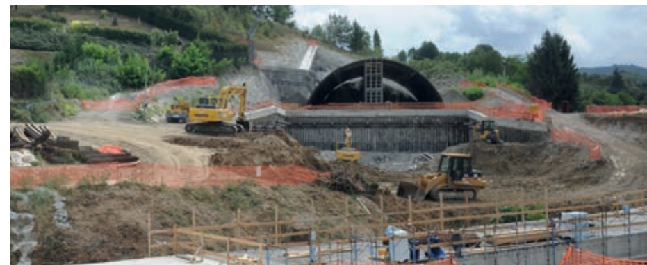
Seit Langem geplant, endlich im Bau: Die Hochgeschwindigkeitsstrecke Tortona/Novi Ligure-Genua. Tunnelanschlag bei Arquata Scrivia mit Bachunterquerung im Vordergrund.
