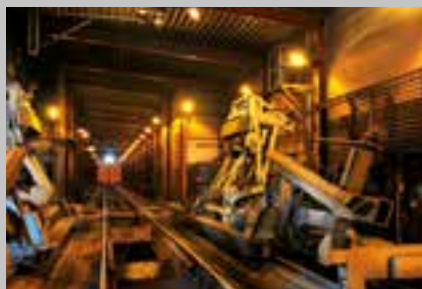
In der Entladeanlage für Erzzüge in Luleå.
