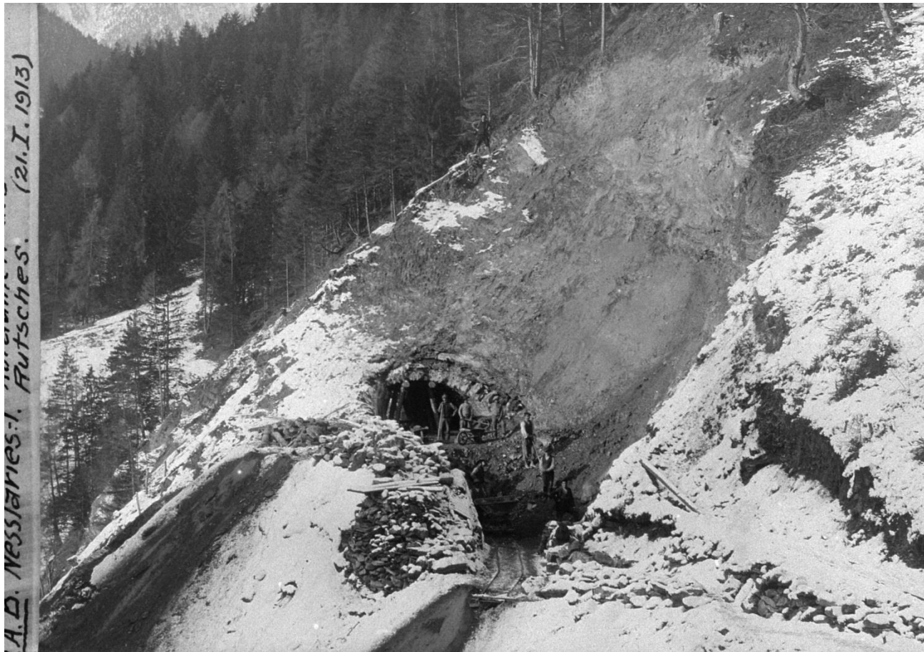
Nesslaries-Tunnel 19m (km 3.4) Rutsch 21.1.13
