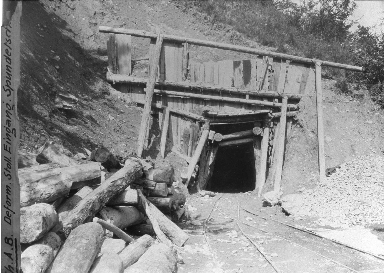
Spundetscha-Tunnel 283m (km 5.0) Druckzone
