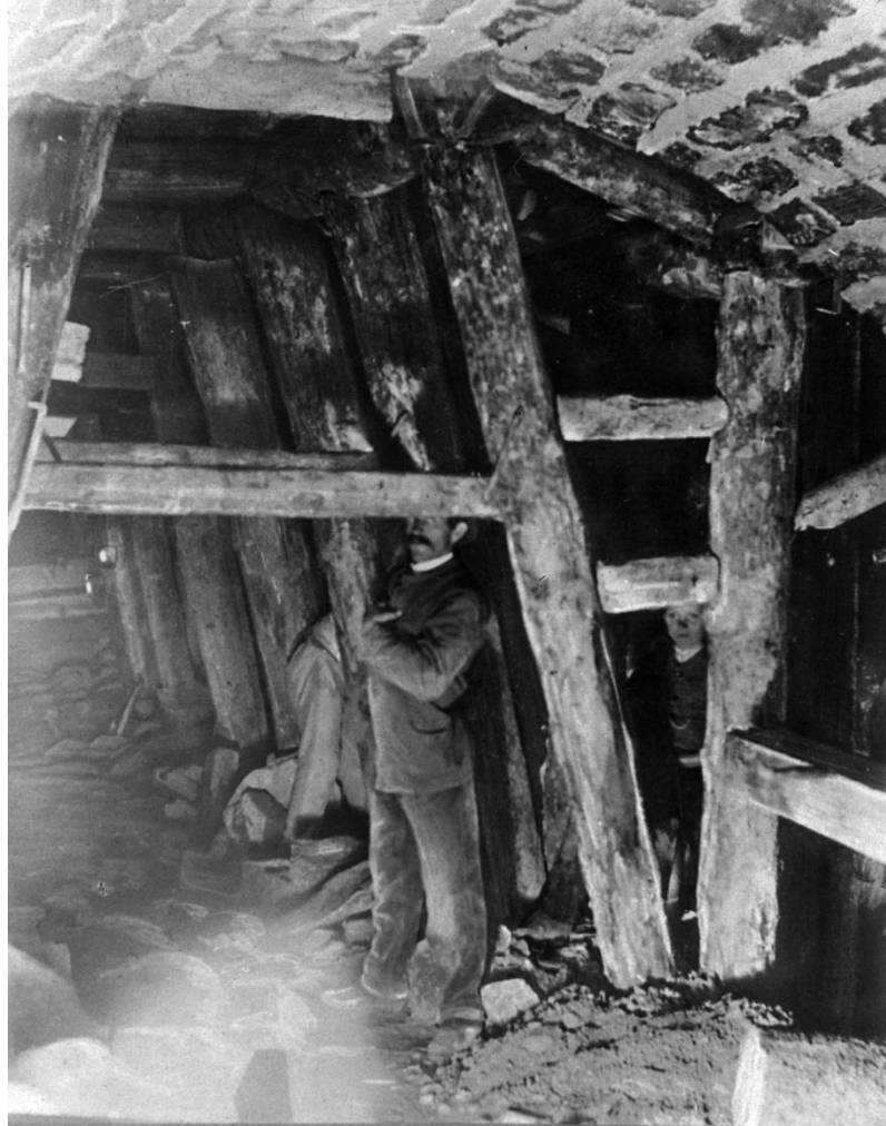
Einbau d. Druckpart. Stuls-T.
