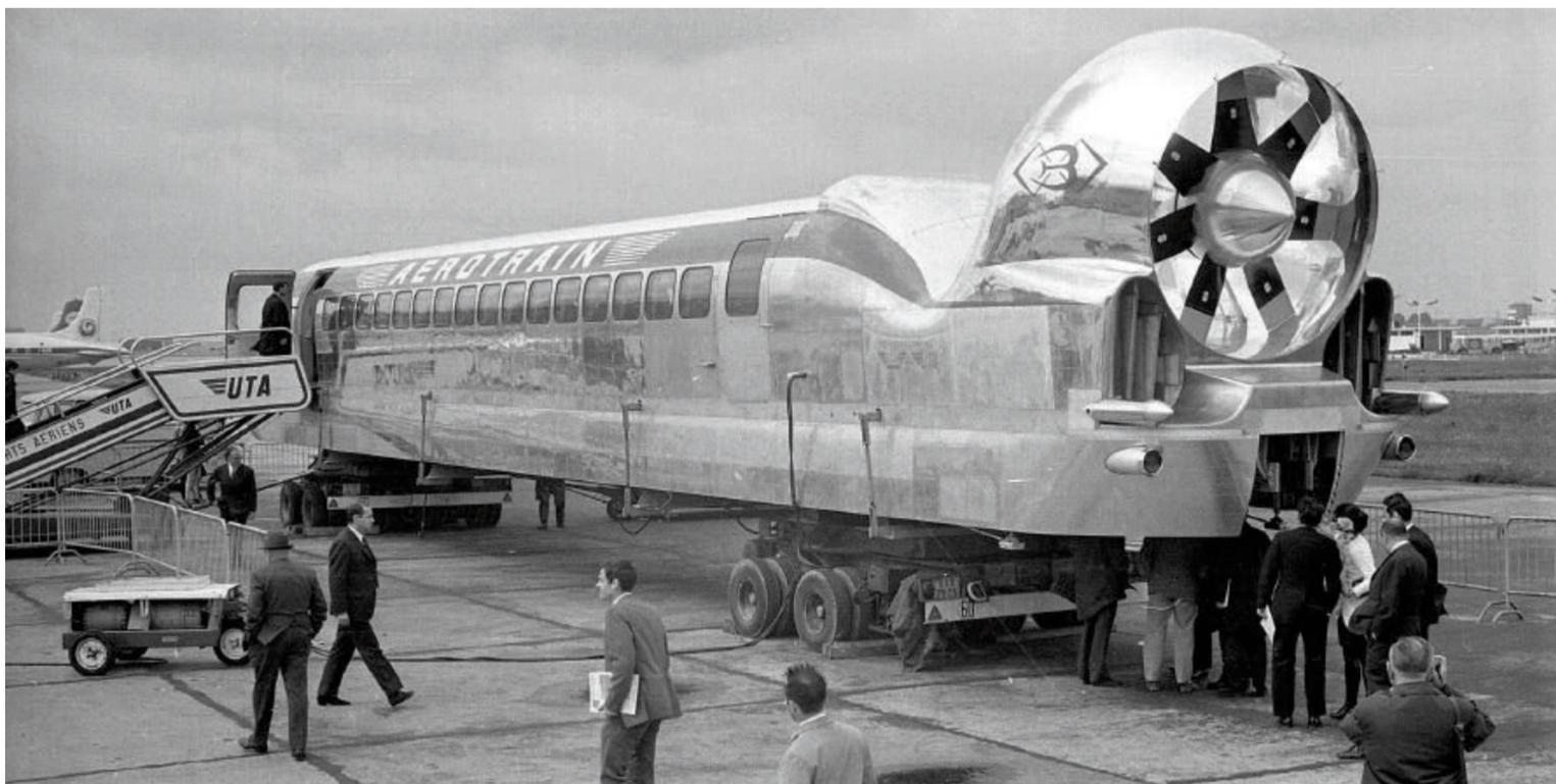
Der Aérotrain sollte auf Luftkissen schweben und von Flugmotoren angetrieben werden, doch durchgesetzt hat sich die Eisenbahn. Foto: J. Cuinières (Roger-Viollet)
