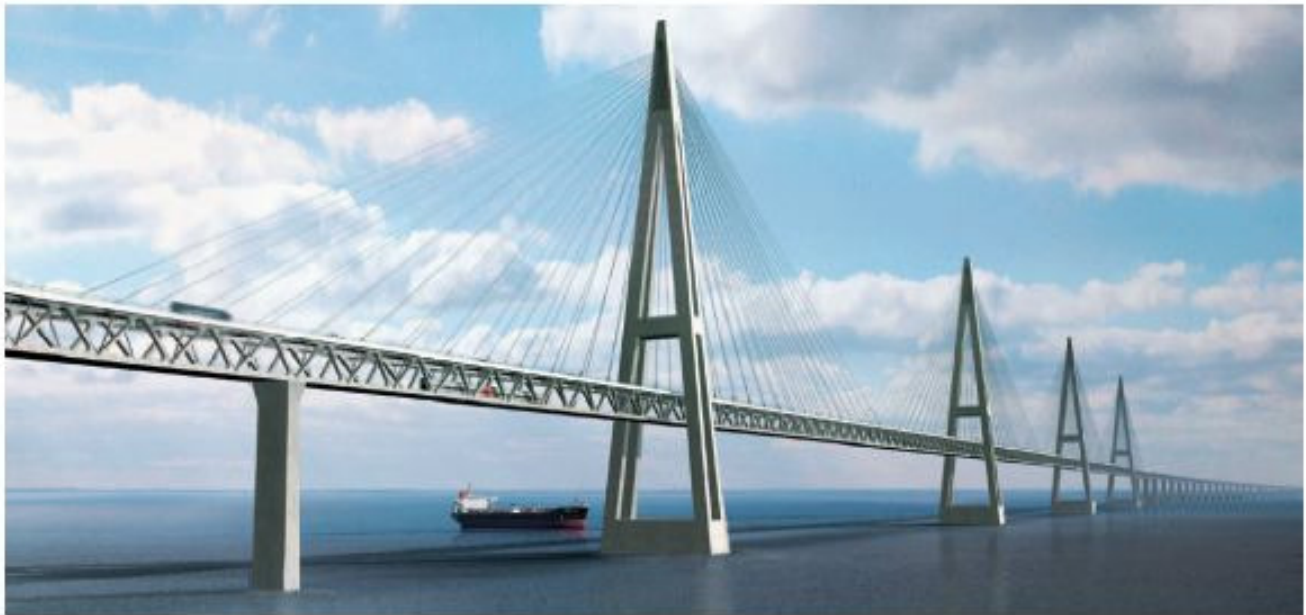
Traversée du détroit de Fehmarn Bælt: long de 19 km, le pont à haubans serait le plus long du genre au monde (simulation; Fehmarn A/S).
