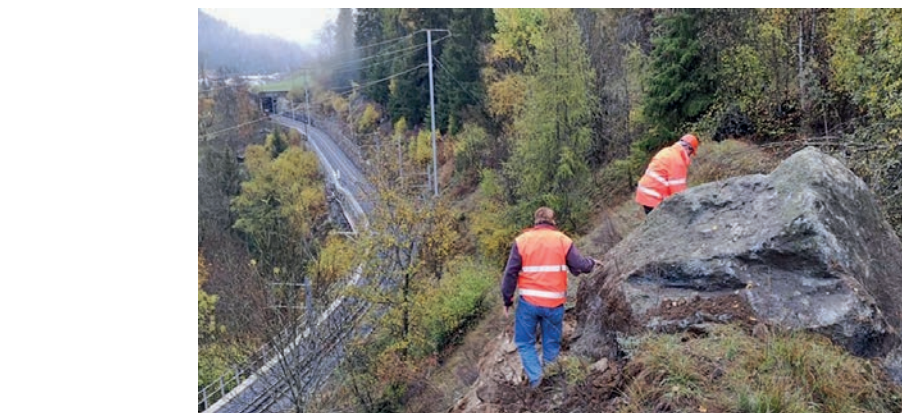
Schutzmassnahmen: Dieser Felsbrocken blieb 2019 bei St. Niklaus in einem Schutzdamm hängen. Bild: zvg
