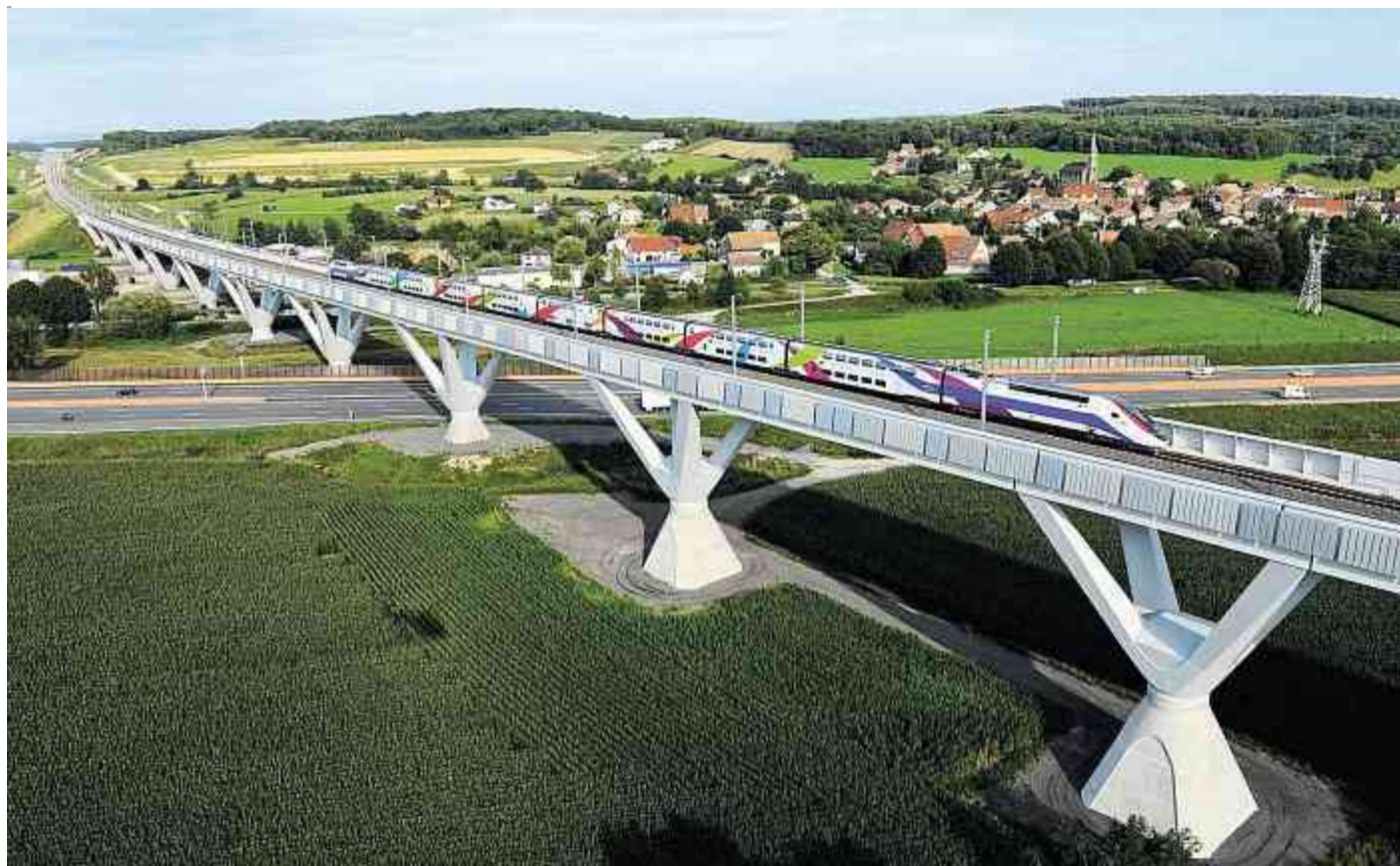
Ein grosszügiger Viadukt bei Savoureuse-Bermont auf der neuen TGV-Strecke zwischen Mulhouse und Dijon.
