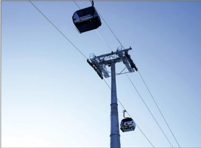
Kuppelbare Einseil-Umlaufbahn Grindelwald–Holenstein – kuppelbare Umlaufbahnen erlauben, Kabinen an den Stationen zum Aus- und Einsteigen auszukuppeln während die anderen weiterlaufen.
