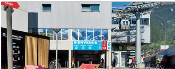
In Le Châble vereint die normalspurige Bahnstation der Transports de Martigny et Régions (TMR) den unterirdischen Bahnhof, zwei Seilbahnen, eine Fahrradstation und drei Postautolinien. Aufnahme: Commune-Val-de-Bagnes
