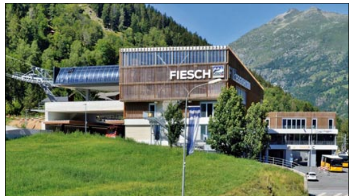
In Fiesch wurde 2019 der 45 Mio. CHF (43 Mio. EUR) teure ÖV-Hub eröffnet, der bequemes Umsteigen von der Matterhorn-Gotthard-Bahn und dem Postauto auf die Seilbahn zum Aletsch-Gebiet erlaubt. Die Einführung einer weiteren Seilbahn ist geplant. Aufnahme: Gemeinde Fiesch
