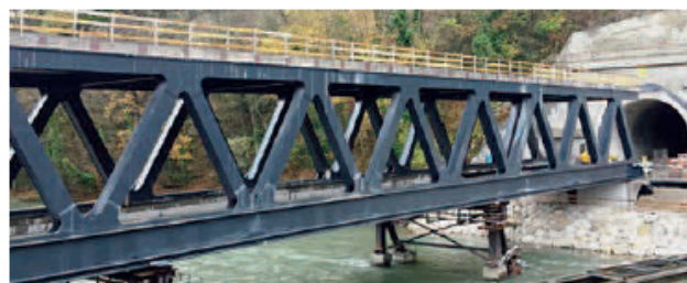
Der Bau der CEVA liegt im Zeitplan
