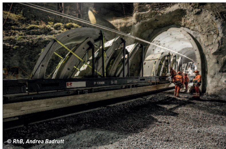
De gauche à droite et de haut en bas : à Preda, UM de Ge 4/4 I avec un train au départ de la base chantier nord du tunnel de l'Albula II (mai 2016) ; rameau entre le tunnel Albula I et le futur tunnel Albula II (mai 2016) ; pose de voussoirs dans le Gletscherastunnel.
