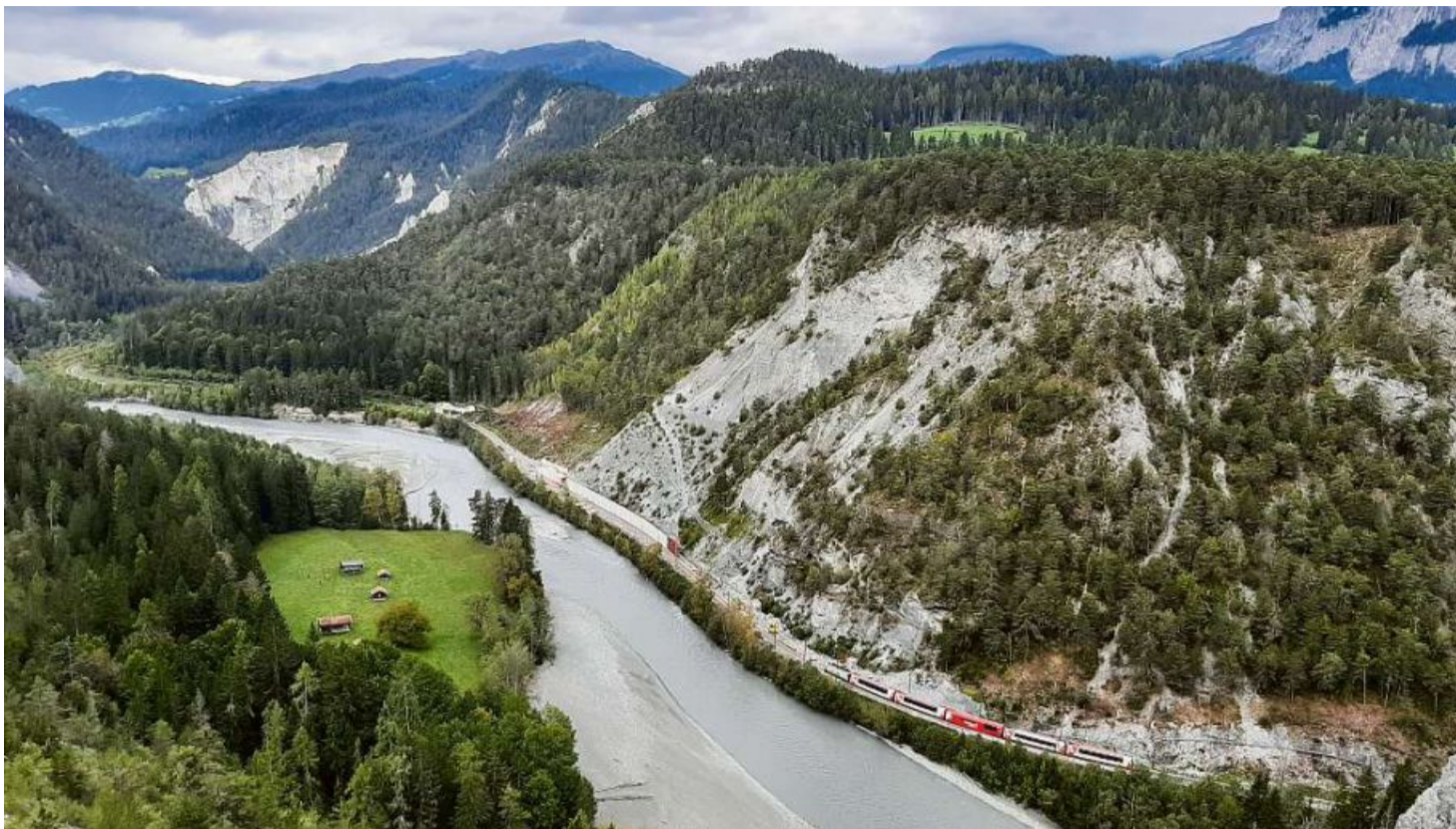
Vesta viers la Surselva culla spunda da Ransun e la galleria nova en construcziun.
