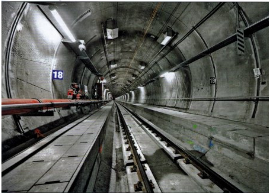
Abb. 5: Der Liefenshoek-Tunnel verbindet die beiden Teile des Hafens von Antwerpen.
