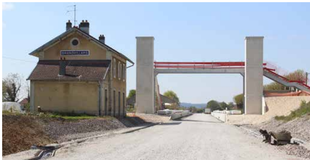
Baustelle am Bahnhof Grandvillars.
