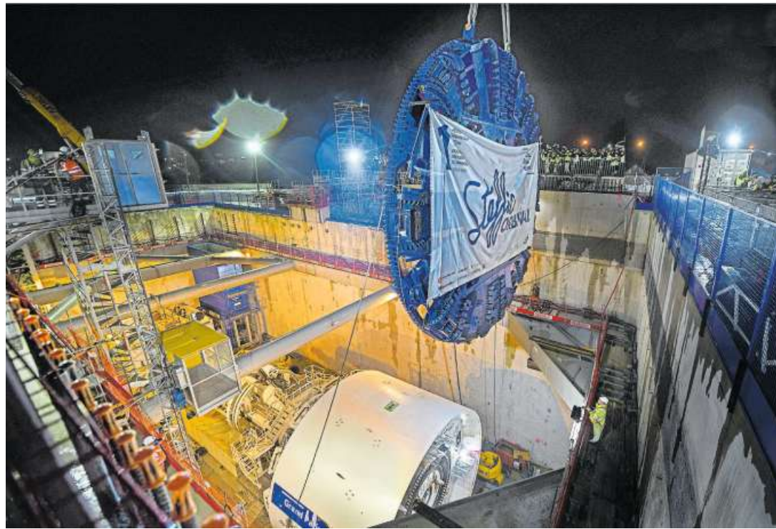
Montage der zweiten Tunnelbohrmaschine auf der Linie 15 Süd Los T2C.
