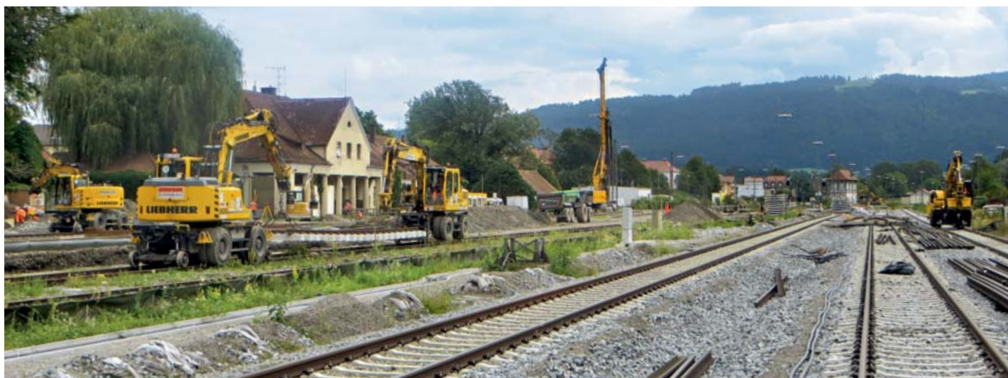
Unten: Der Umbau des Bahnhofs Lindau-Reutin zur Verkehrsstation mit vier Bahnsteiggleisen sowie einigen Abstellgleisen (rechts) ist in vollem Gang. Das Bahnhofsgebäude links hinten wird noch abgebrochen (Foto: M. Rellstab, 13. August 2019).
