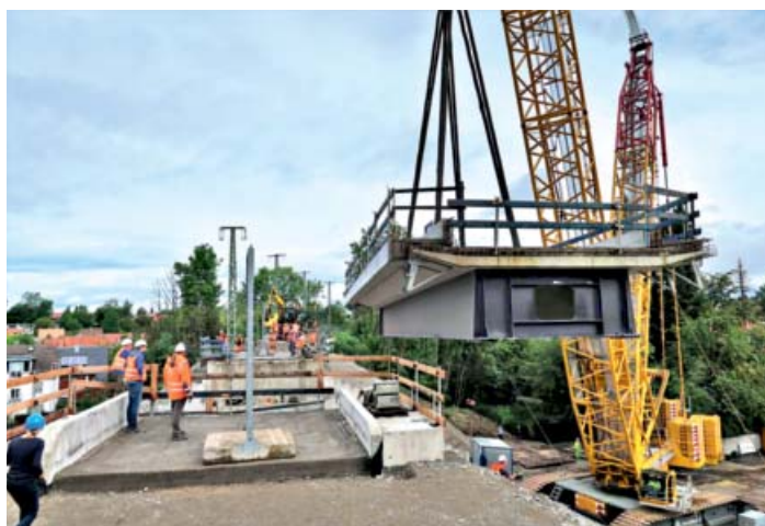
Links: Ein 650-Tonnen-Raupenkran hebt in Wangen den 280 Tonnen schweren Brückenüberbau in die vorge-sehene Lage über der Lindauer Strasse (Foto: DB, 19. August 2019).
