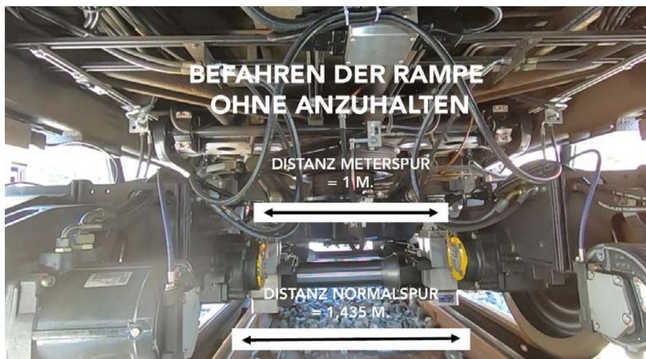
Die Umspuranlage in Zweisimmen: Dank innovativer Drehgestelle können die MOB-Wagen von der Meterspur auf die Normalspur wechseln.
