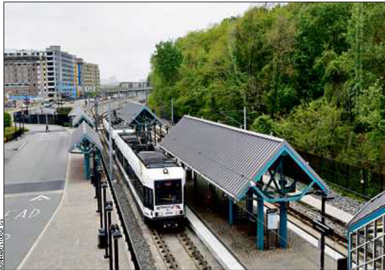
La ligne Hudson-Bergen à Jersey City. Pour réduire l'emprise aérienne des câbles d'alimentation, la municipalité a retenu la solution compacte réunissant supports, isolateurs et câbles du suisse Kummner + Matter. ARCHIVES
