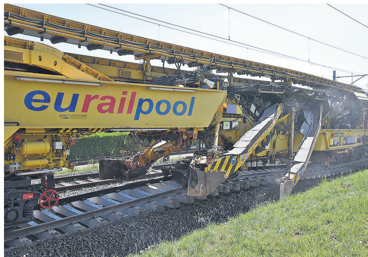
Mit dieser Maschine wird der Altschotter unter dem angehobenen Gleisrost ausgehoben. Anschliessend gelangt er über Förderbänder in die Recycling-Waschanlage.
