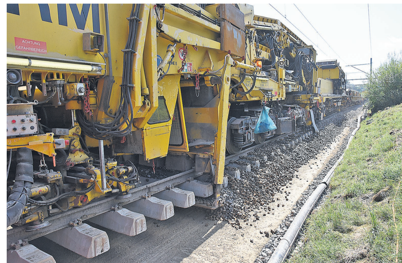
Am Schluss wird der recycelte, gewaschene Schotter zusammen mit dem Neuschotter unter dem Gleisrost verteilt und unter die Schwellen gestopft.
